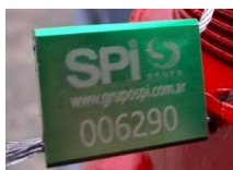
FOTO VALVULA DE SEGURIDAD
